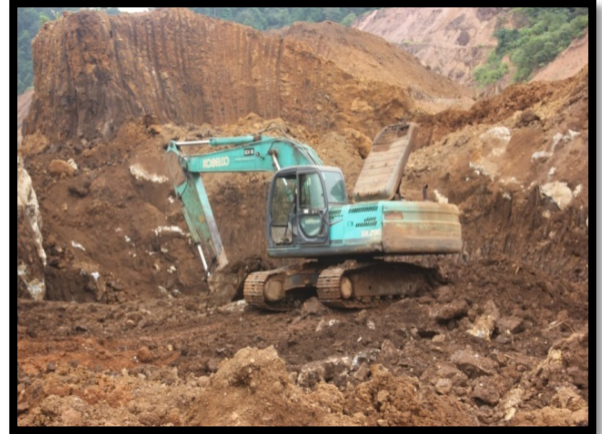
Figure 3.5 မြေစာများသယ်ဆောင်ခြင်း - အဖြိုက်နက်နှင့် သံဖြူရောနှောနေသော နန်းမြေများကို မြေသယ်ကားသို့ သယ်သွားပုံ အလေအလွင့်များ မဖြစ်စေရန် လေ့ခါးထပ်ပုံစံ ခုံတန်းရှည်များကို မြေတူးစက်ဖြင့် ပြုလုပ် ထားပါသည်။ ခုံတန်းရှည်သည် ၆၀ ဒီဂရီစောင်း၍ အမြင့် ၁၀ မီတာခန့် ရှိပါသည်။
